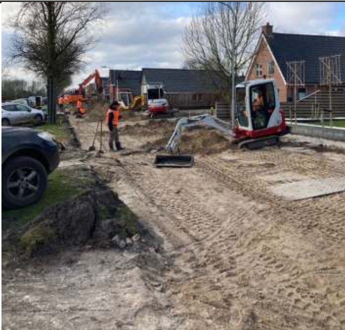
Tijdens rioolwerkzaamheden die onder het fietspad door moeten ligt het fietspad open. Er wordt dan een aluminium loop / fietsbrug geplaatst over het fietspad.
