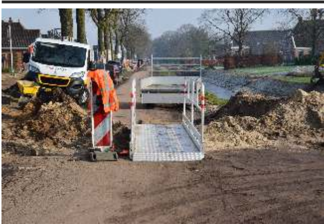
Tijdens rioolwerkzaamheden die onder het fietspad door moeten ligt het fietspad open. Er wordt dan een aluminium loop / fietsbrug geplaatst over het fietspad.
